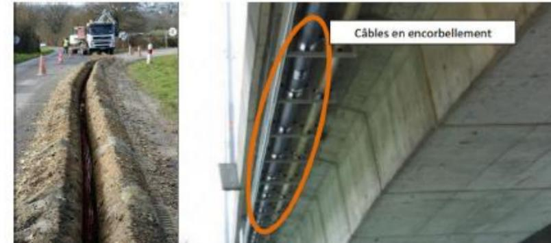
2. Passage sur le pont. Description technique : découpe à la scie du trottoir béton (environ 5ml), puis un terrassement sur le tablier à environ 50 cm avec pose de fourreaux TPC 160, génératrice supérieure des fourreaux à -40 cm du TN puis plonger à -80 cm dans les extrémités pour reprendre la profondeur réglementaire en accotement, béton de tranchées à prévoir sur les fourreaux et de part et d'autre du pont, reconstitution du trottoir en béton.
